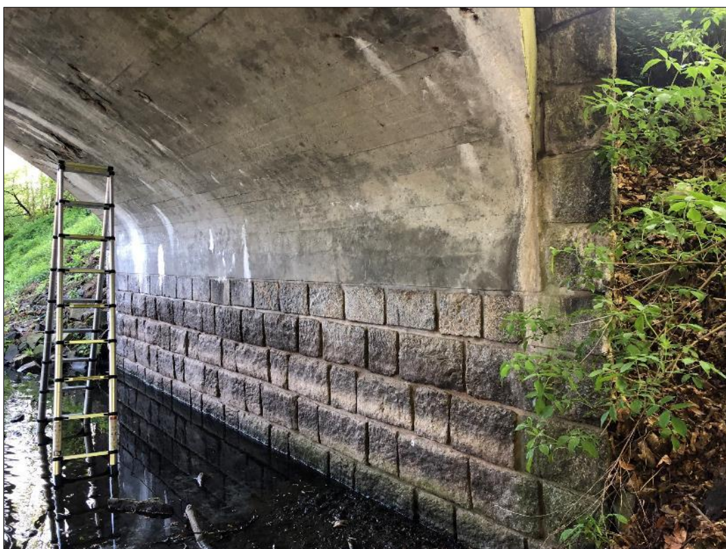
Foto 14: Pohled na spodní stranu klenby u opěry směr Benešov, lokální zatékání a výluhy
