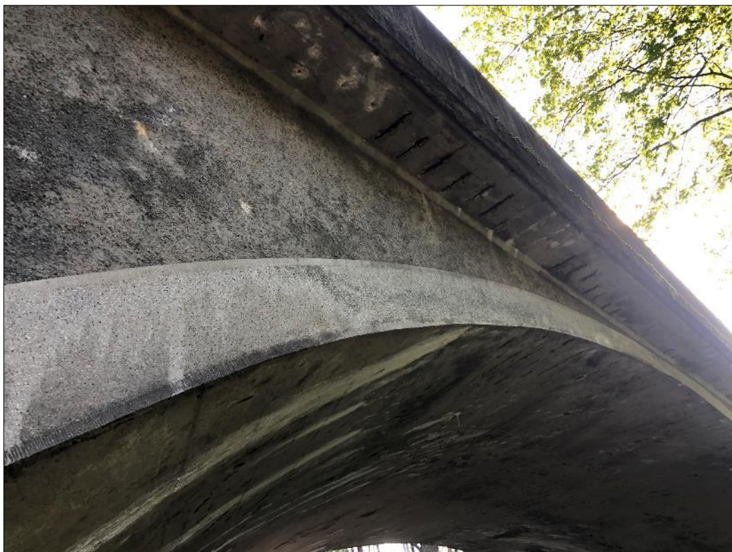
Foto 9: Pohled na povodní stranu mostu, patrné prokreslení výztuže na římse, lokální zatékání a výluhy
