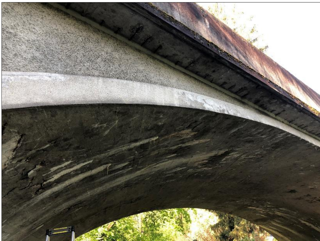
Foto 21: Pohled na návodní stranu mostu, patrné prokreslení výztuže na římse, lokální zatékání a výluhy
