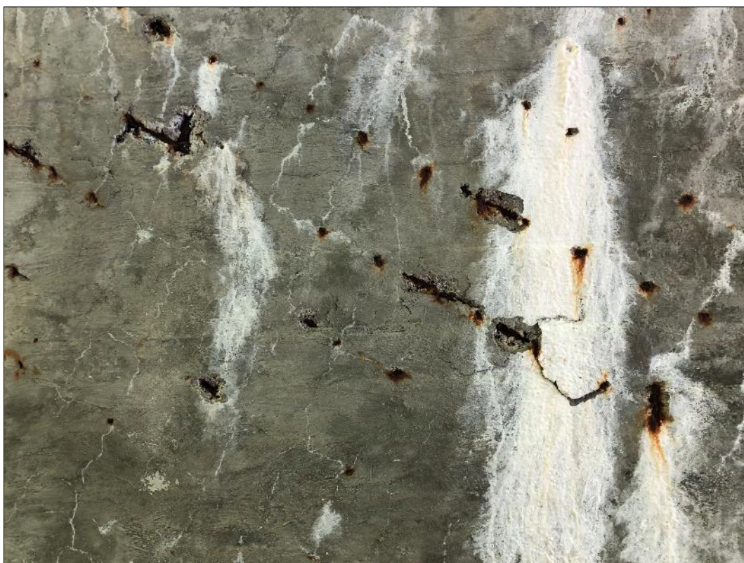
Foto 6: Pohled na spodní část klenby u opěry směr Václavice, patrné průsaky a koroze distančních vložek, lokální odlupování krycí vrstvy výztuže
