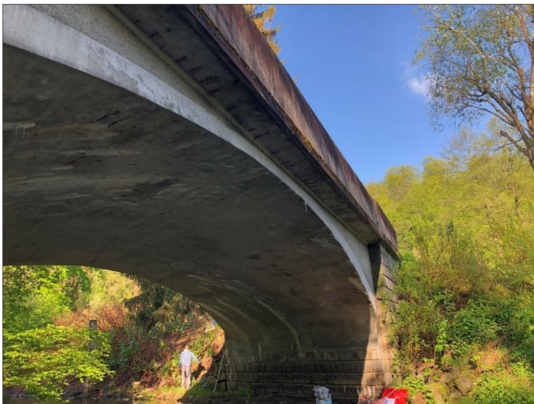
Foto 22: Pohled na návodní stranu mostu, patrné prokreslení výztuže na římse, lokální zatékání a výluhy
