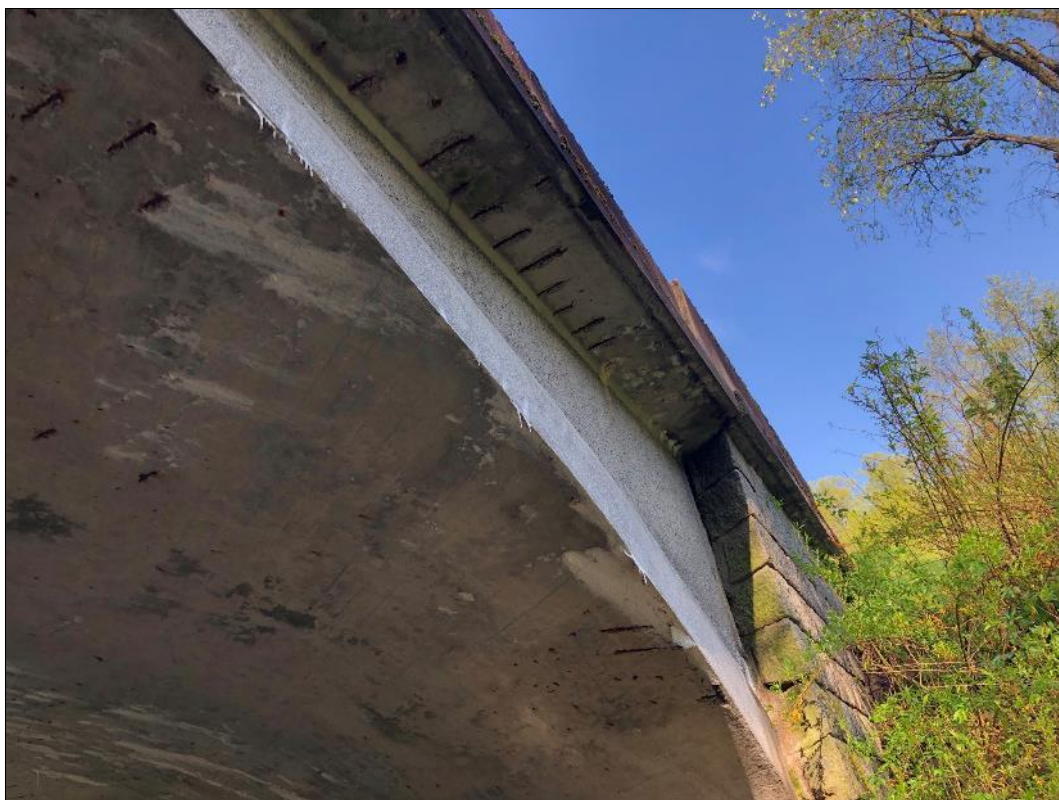
Foto 24: Pohled na návodní stranu mostu, patrné prokreslení výztuže na římse, lokální zatékání a výluhy
