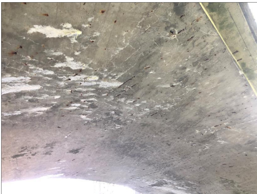
Foto 11: Pohled na spodní stranu klenby, lokální zatékání a výluhy
