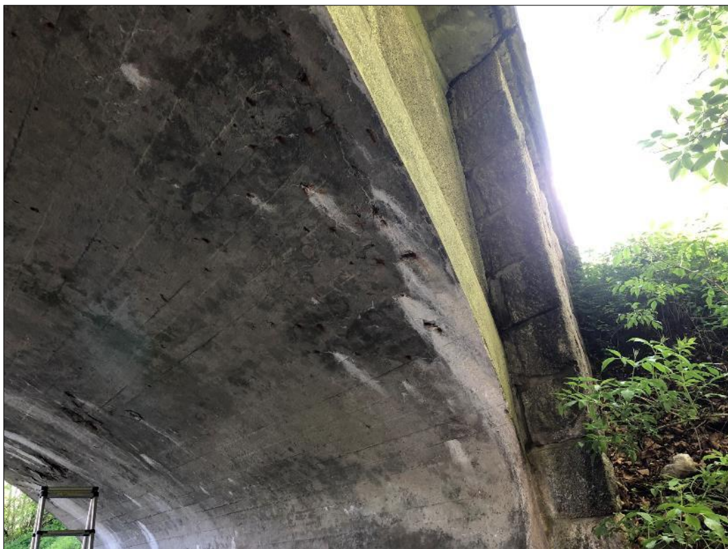
Foto 13: Pohled na spodní stranu klenby u opěry směr Benešov, lokální zatékání a výluhy
