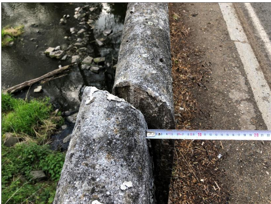
Foto 31: Detail styku parapetní římsy v místě napojení křídla a opěry na povodní straně, patrné rozevírání konstrukcí
