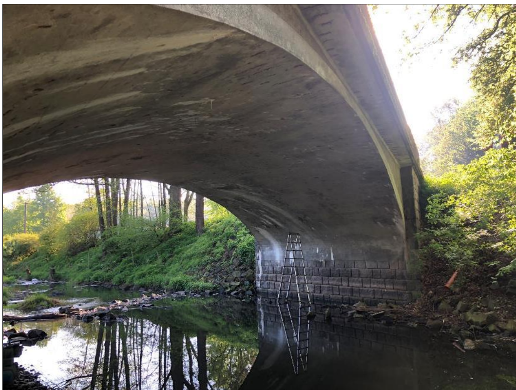
Foto 10: Pohled na povodní stranu mostu, patrné prokreslení výztuže na římse, lokální zatékání a výluhy
