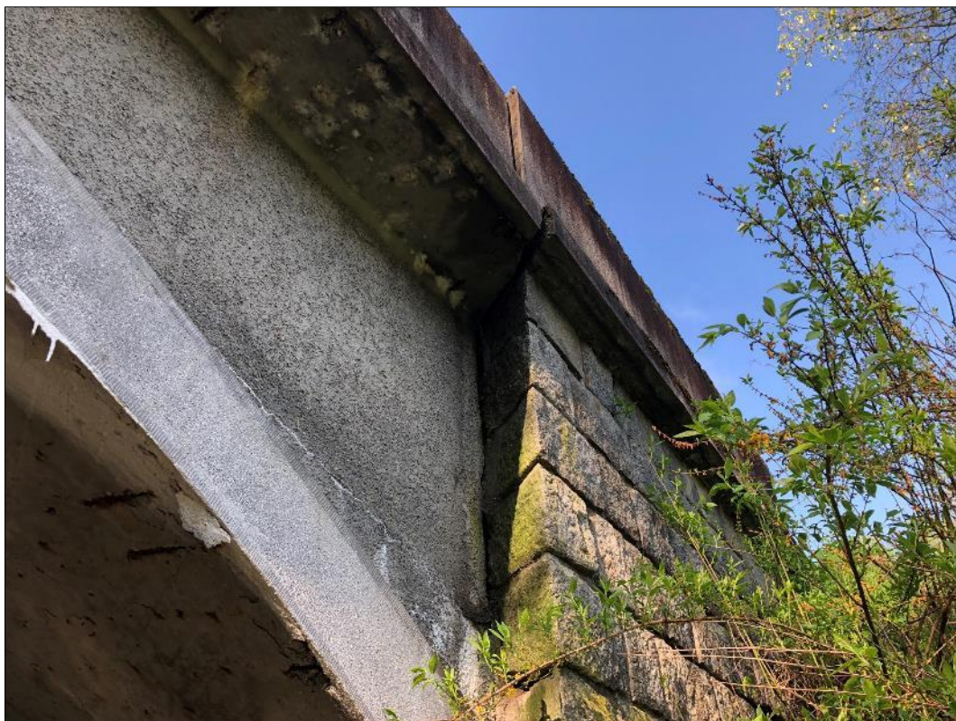
Foto 25: Pohled na spáru mezi křídlem a opěrou
