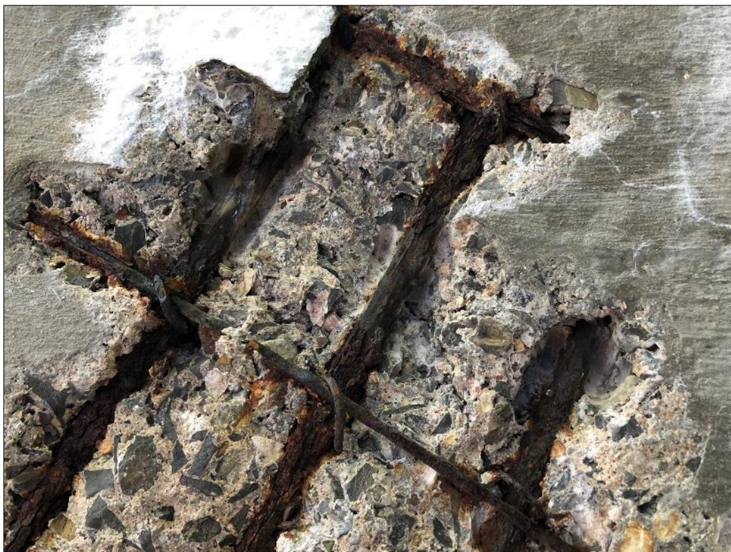
Foto 7: Detail hlavní výztuže klenby, sonda č.1 – nalezena hlavní výztuž průměru 20 mm, typ C (hladká), rovnoběžná s osou mostu (pnutá mezi opěrami), krycí vrstva betonu 10-15 mm, rozteč 90-110 mm, povrchová koroze výztuže, rozdělovací výztuž průměru 8 mm (koroze způsobuje lokální oslabení až na 5 mm), typ C (hladká), krycí vrstva betonu 5-10 mm
