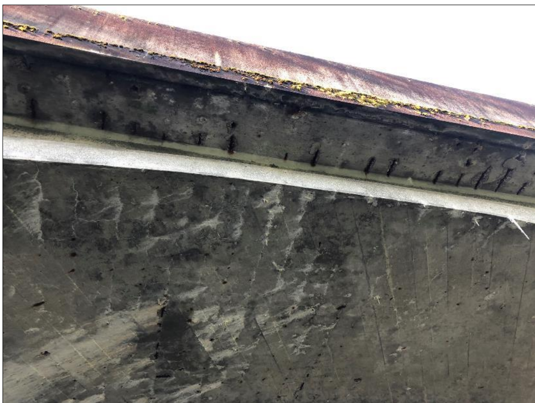
Foto 23: Pohled na návodní stranu mostu, patrné prokreslení výztuže na římse, lokální zatékání a výluhy
