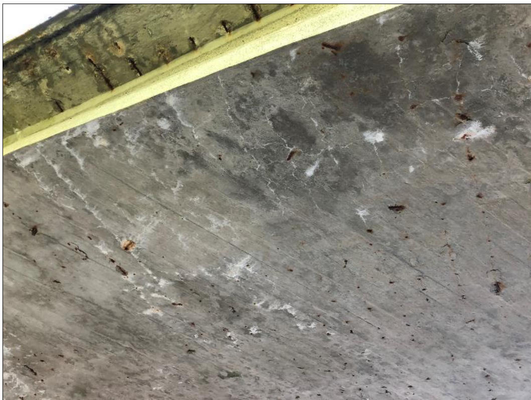
Foto 12: Pohled na spodní stranu klenby, lokální zatékání a výluhy, koroze výztuže v římse
