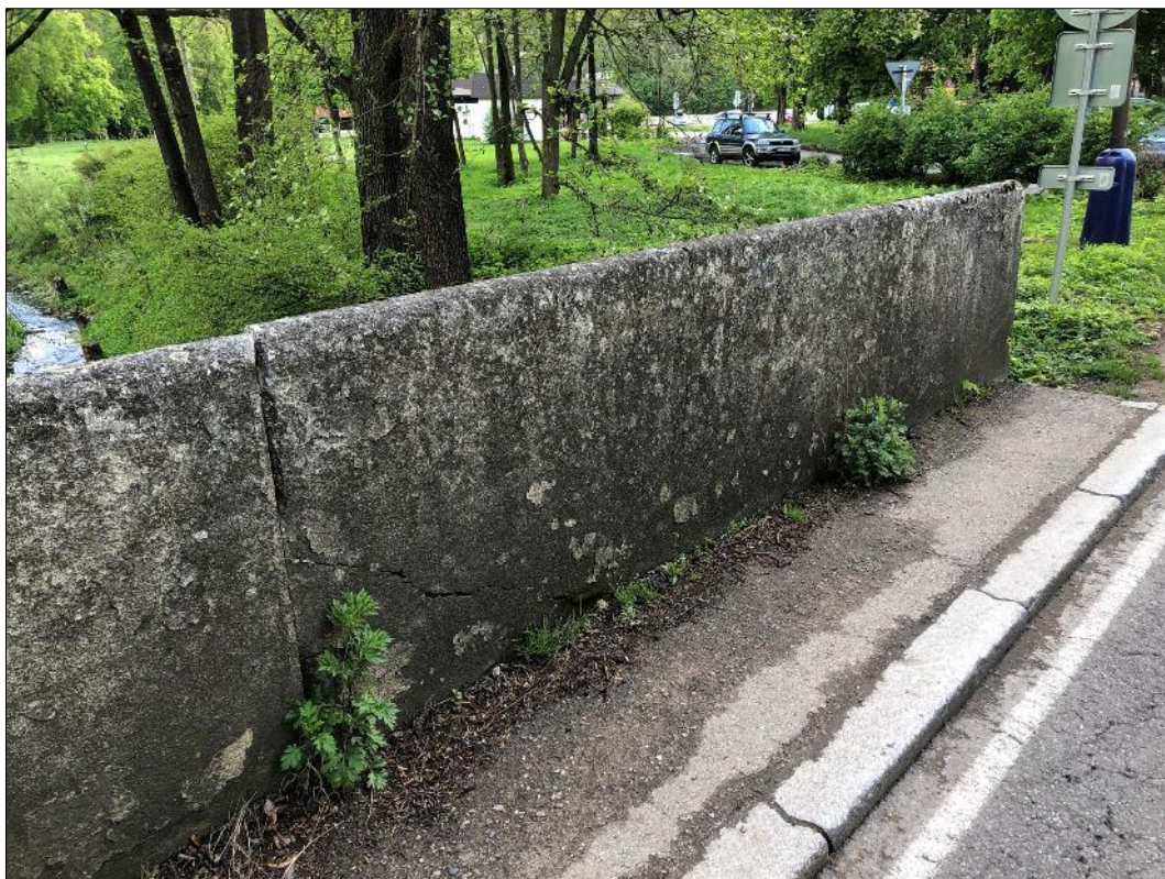
Foto 27: Pohled na parapetní římsu na povodní straně, patrná diagonální trhлина
