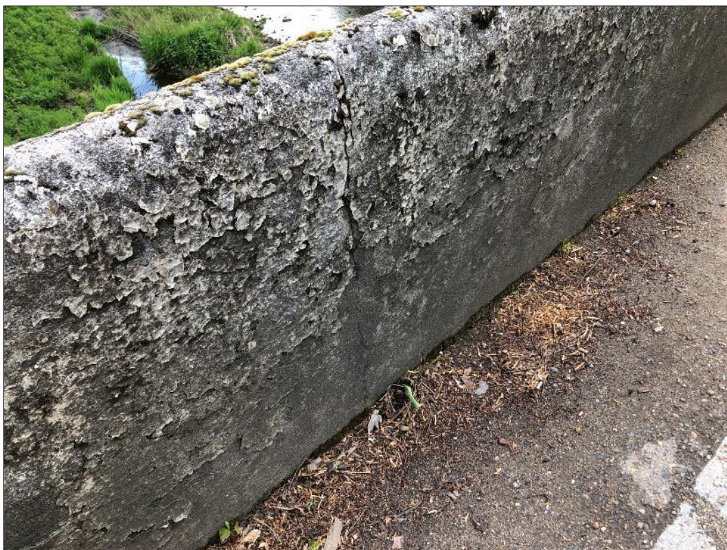
Foto 28: Pohled na parapetní římsu na povodní straně, patrná svislá trhлина
