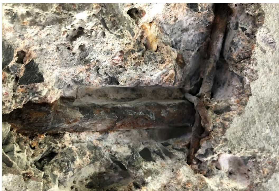
Foto 8: Detail hlavní výztuže klenby, sonda č.2 – nalezena hlavní výztuž průměru 20 mm, typ C (hladká), rovnoběžná s osou mostu (pnutá mezi opěrami), krycí vrstva betonu 10-15 mm, povrchová koroze výztuže, rozdělovací výztuž průměru 8 mm, typ C (hladká), krycí vrstva betonu 5-10 mm
