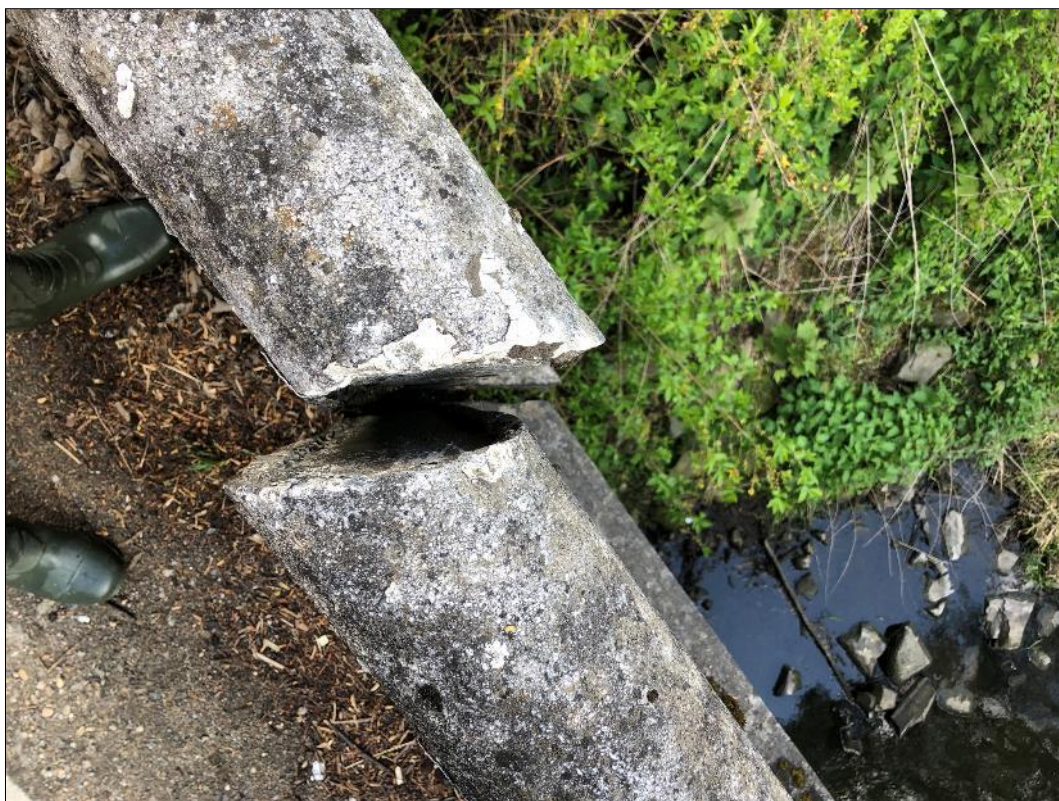
Foto 30: Detail styku parapetní římsy v místě napojení křídla a opěry na povodní straně, patrné rozevírání konstrukcí
