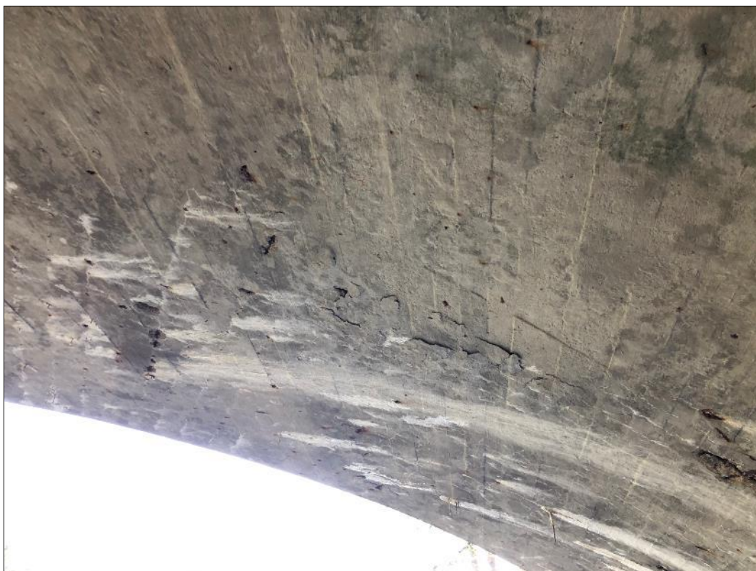
Foto 16: Pohled na spodní stranu klenby u opěry směr Benešov, odlupování krycí vrstvy vlivem zatékání
