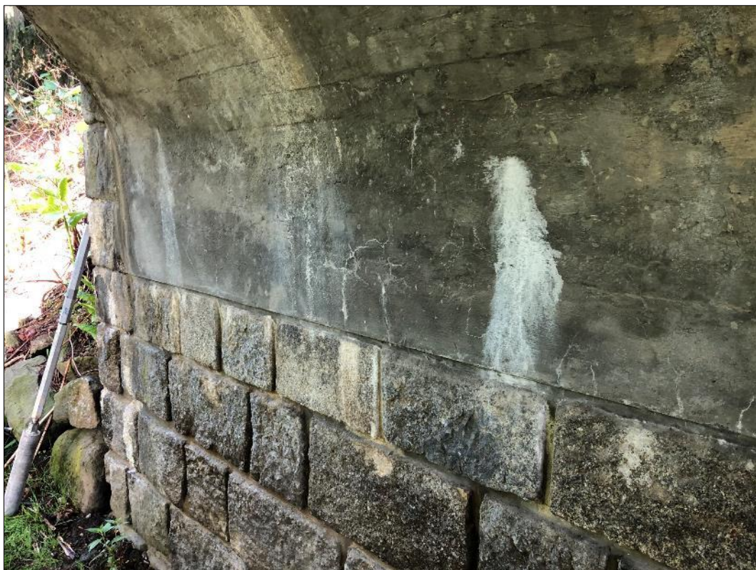
Foto 5: Pohled na spodní část klenby a opěry směr Václavice, patrné lokální průsaky
