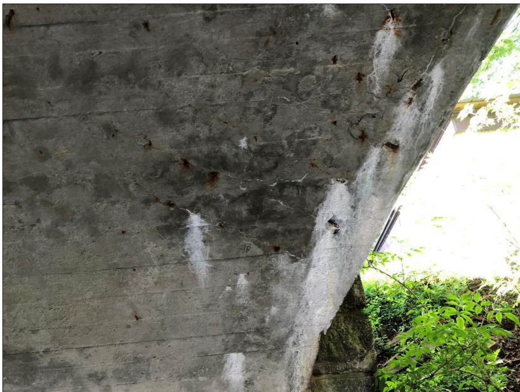
Foto 15: Pohled na spodní stranu klenby u opěry směr Benešov, odlupování krycí vrstvy vlivem zatékání
