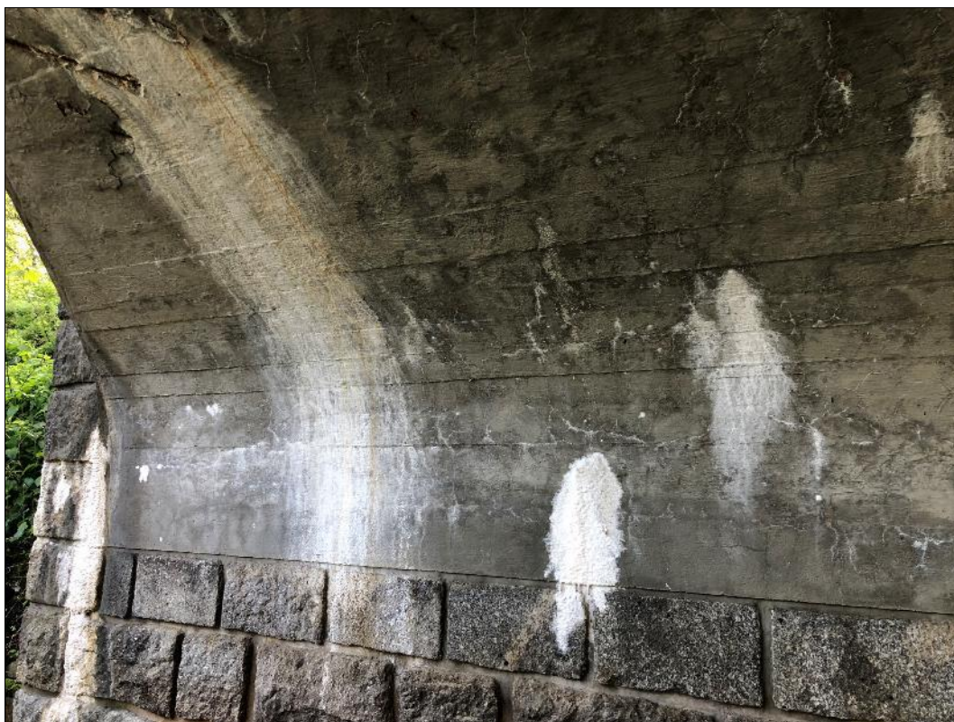
Foto 18: Pohled na spodní stranu klenby u opěry směr Benešov, odlupování krycí vrstvy vlivem zatékání, výluhy
