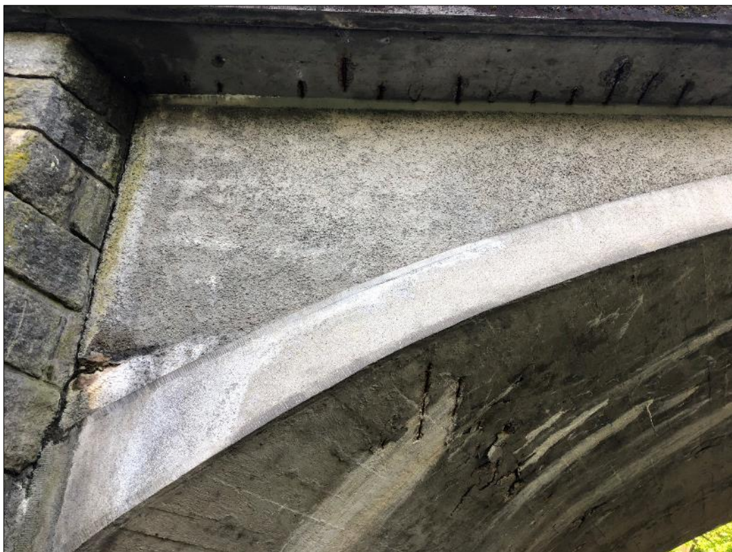
Foto 19: Pohled na návodní stranu mostu, patrné prokreslení výztuže na římse, lokální zatékání a výluhy
