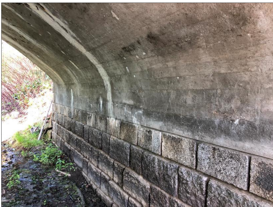
Foto 4: Pohled na spodní část klenby a opěry směr Václavice, patrné lokální průsaky
