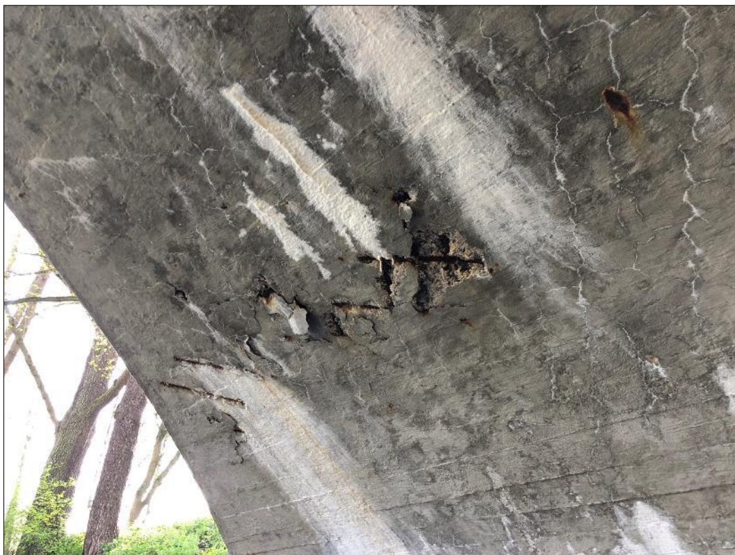
Foto 17: Pohled na spodní stranu klenby u opěry směr Benešov, odlupování krycí vrstvy vlivem zatékání, odhalená výztuž s povrchovou korozí
